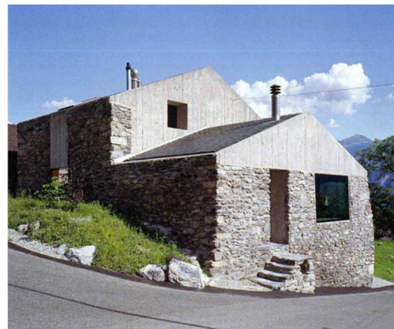
Le bois de l'ancienne construction a été remplacé par du béton.
