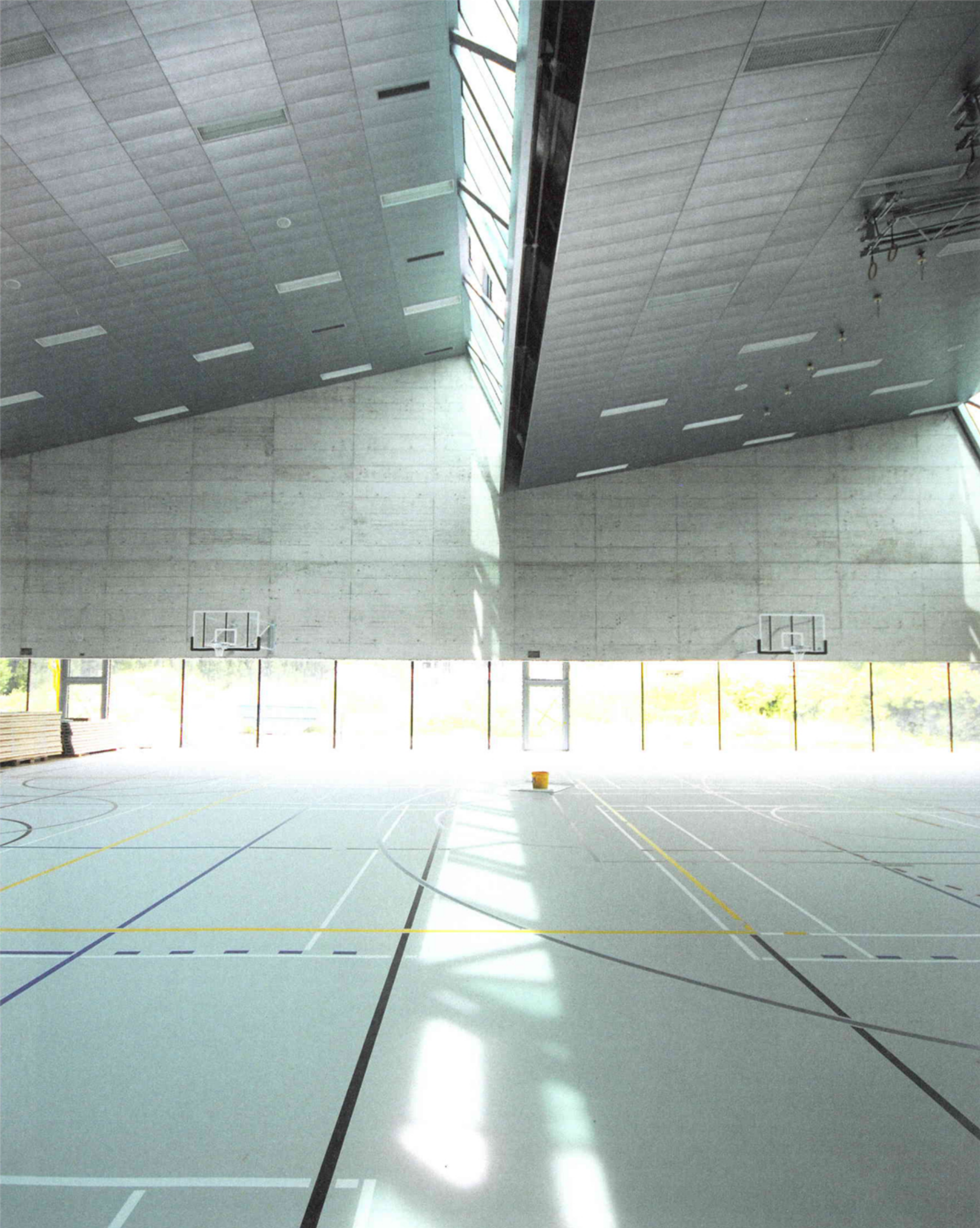
Les trois grandes poutres triangulées (environ 26 mètres de long pour 4 mètres de haut) qui ferment les sheds, livrées chacune d'une pièce, sont elles aussi des éléments d'un certain effet.
